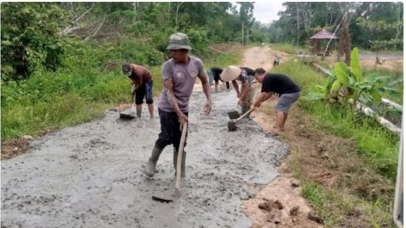
Pemdes Mulya Agung Bekerjasama PT. Hutama Bangun Jalan Desa
