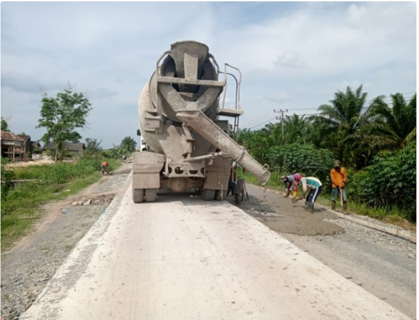
Bangun Jalan Rigid Beton KTM Wonosari
